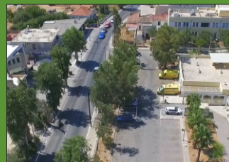
Κόμβος Ι.Κ.Α. - Πινακίδα VMS - Ρυθμιστές κυκλοφορίας
